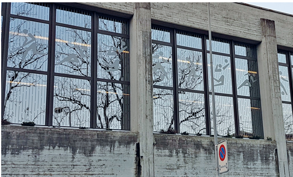
Abbildung 6: Sporthallen sind wegen starker Spiegelung auf grosser Fläche oft eine Gefahr. Hier wurde mit Kristallfolie vorbildlich nachgerüstet. © Dominik Rüede
