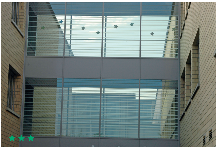
Abbildung 13: (oben) und 14 (unten): Klar abgegrenzte, kontrastierende Linien reduzieren das Risiko für Vogelkollisionen und gestatten z.B. bei Fussgängerüberführungen trotzdem eine hohe Durchsicht. © Wiener Umwelthanwaltschaft, Wilfried Doppler; Archiv Schweizerische Vogelwarte (14)
