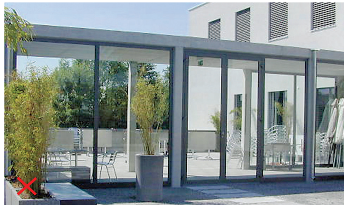
Abbildung 16: Transparente Verbindungsgänge, Pausenhallen und Passerellen fördern immer wieder Kollisionsopfer. © Archiv Schweizerische Vogelwarte
