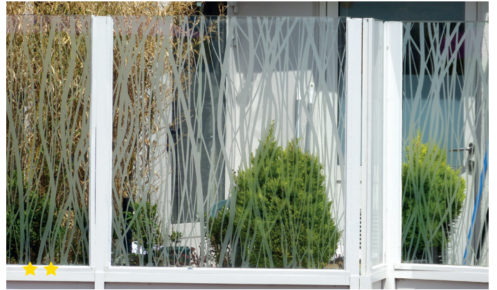
Abbildung 15: Ein pflanzenartiges Design verhindert bei diesem Windschutz Vogelkollisionen. © Archiv Schweizerische Vogelwarte
